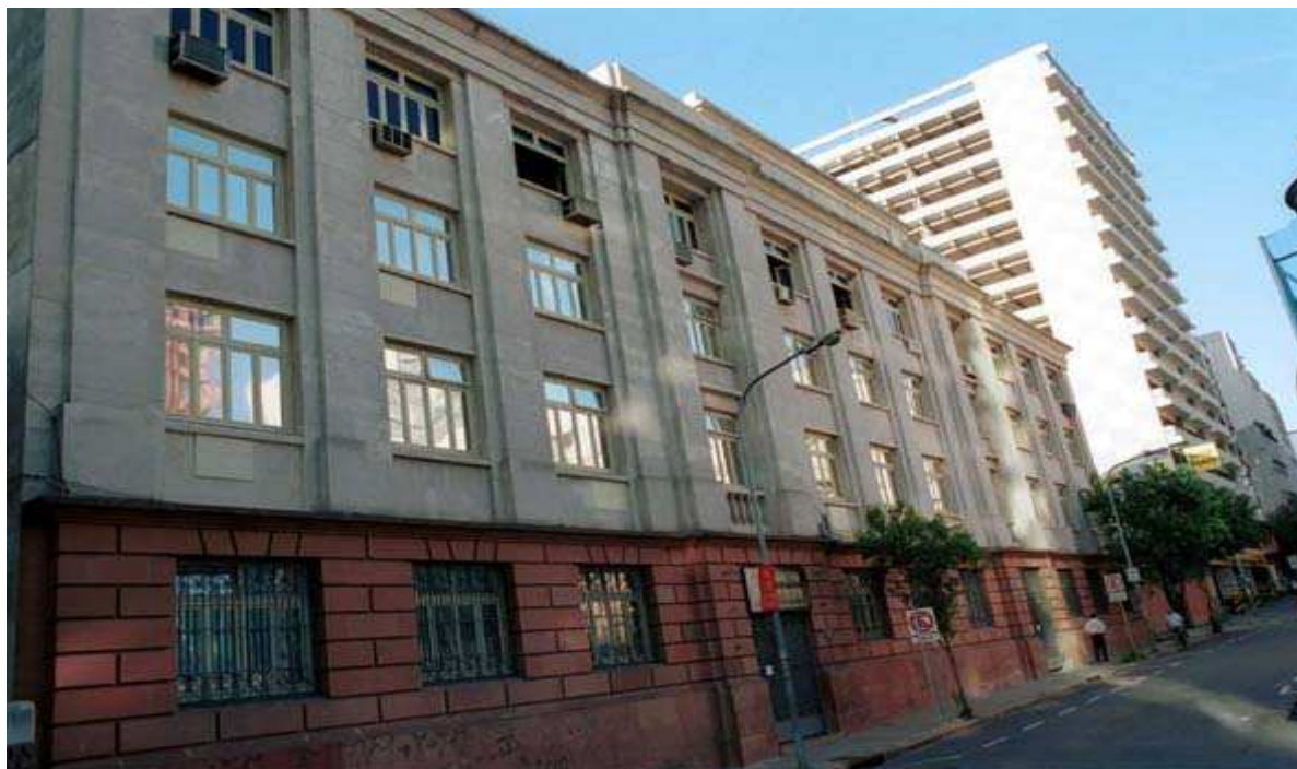
Figura 42 – Foto do Arquivo Público do Estado do Rio Grande do Sul. Edifício administrativo, 1950. Fonte: Família Prati. Disponível em: <fotosantigas.prati.com.br>. Acesso em: 12 dez. 2009.
