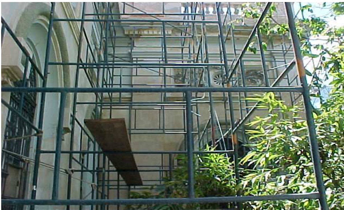
Figura 34– Foto externa, restauração das fachadas. Porto Alegre. Fonte: Acervo APERS.
