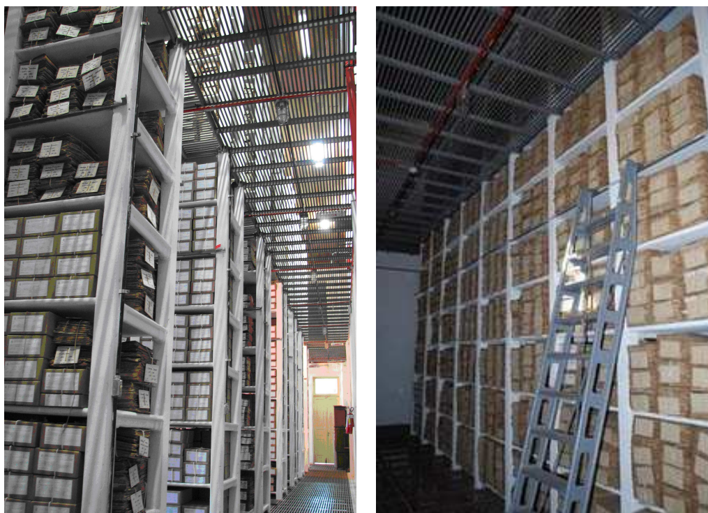
Figura 21 e 22 – Foto da interna do Arquivo Público do Estado do Rio Grande do Sul–Galerias, Estantes de concreto, Pisos vazados em estrutura em ferro, 1910. Porto Alegre: Fonte APERS.
