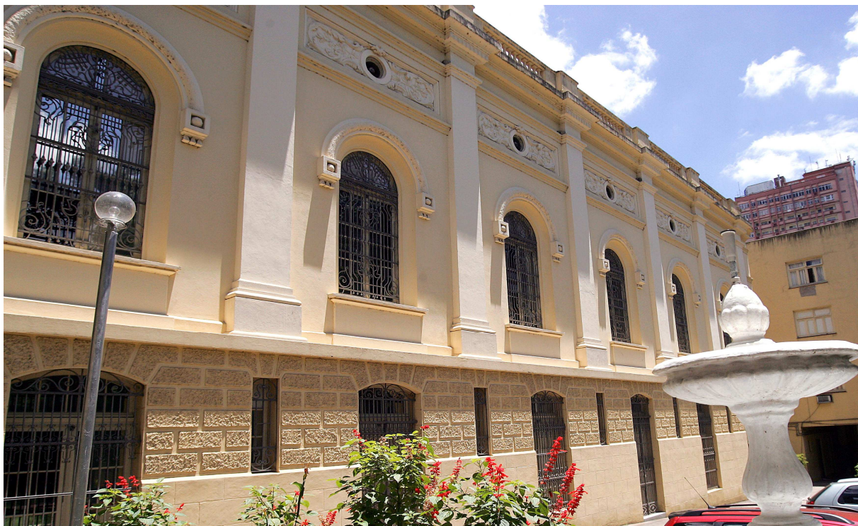
Figura 39 - Foto do prédio 2 após a restauração, 2001. Porto Alegre. Fonte: Acervo APERS.
