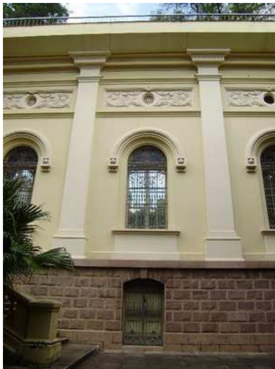
Figura 19 – Foto do Arquivo Público do Estado do Rio Grande do Sul. Representa o prédio em alvenaria e porões em pedra. Porto Alegre. Fonte: Marco Fronckowiak. Disponível em: <bandodebarronoarquivo.com>. Acesso em: 20 maio 2010.
