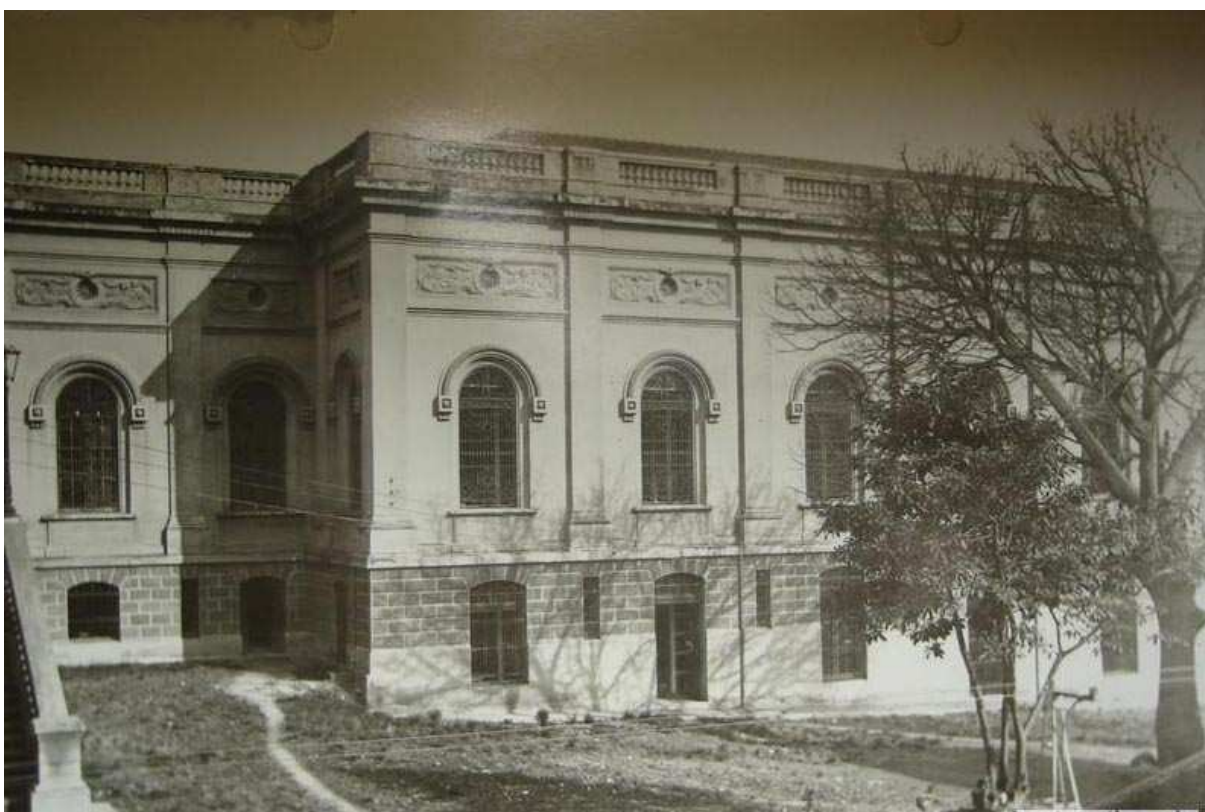
Figura 29 – Foto da ala esquerda do Arquivo Público do Estado do Rio Grande do Sul. Edifício 2ª fase. Fachada principal, 1920, Porto Alegre. Fonte: Família Prati. Disponível em: <fotosantigas.prati.com.br>. Acesso em: 20 dez. 2009.
